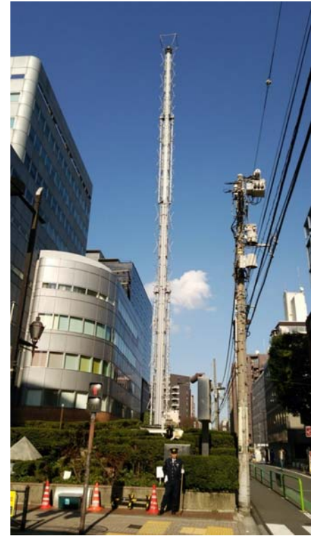
日本テレビの原点ともいえる12段スーパーターンスタイルアンテナ（かつて存在した鉄塔に設置）。
